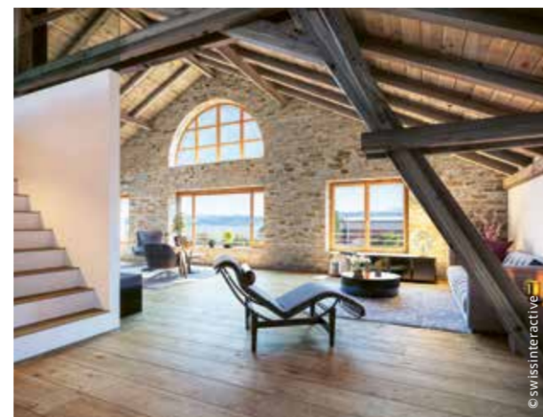
Der historische Dachstuhl aus Holz bleibt sichtbar. Er ergänzt den modernen Innenausbau der zweistöckigen Loftwohnungen.
