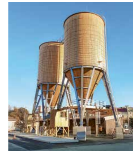
Zwei Rundholzsilos in Wien Stadt mit je 500 m 3 Fassungsvermögen.
