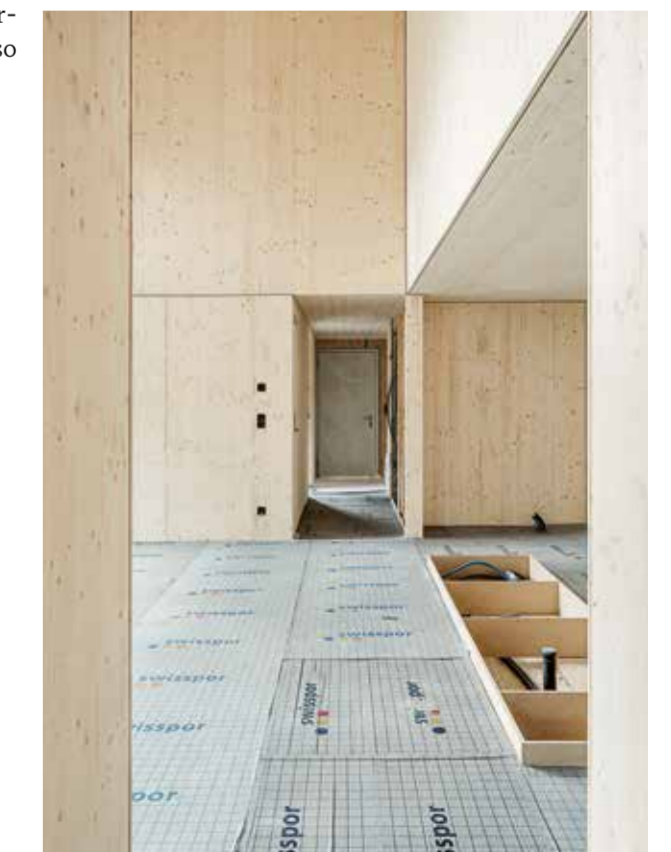
Fichten-Dreischichtplatten bestimmen den Innenausbau.
