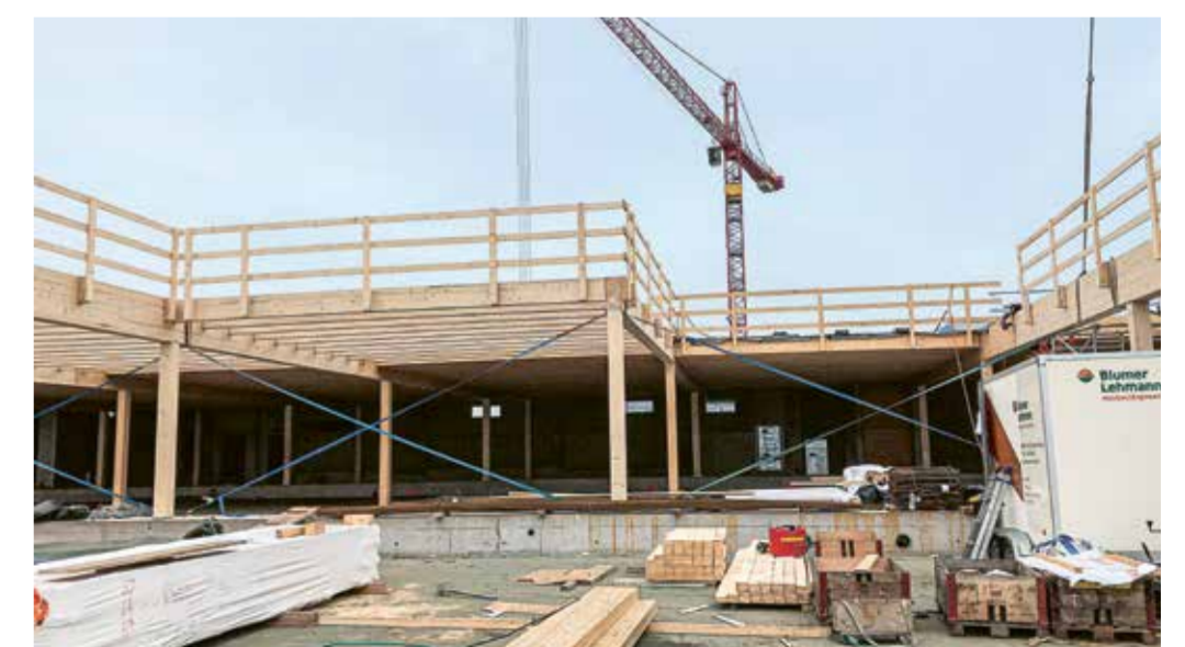
Oben: Das zusätzliche Geschoss in Holzbauweise ist nach Abschluss der Bauarbeiten optisch auf den ersten Blick nicht zu erkennen.
