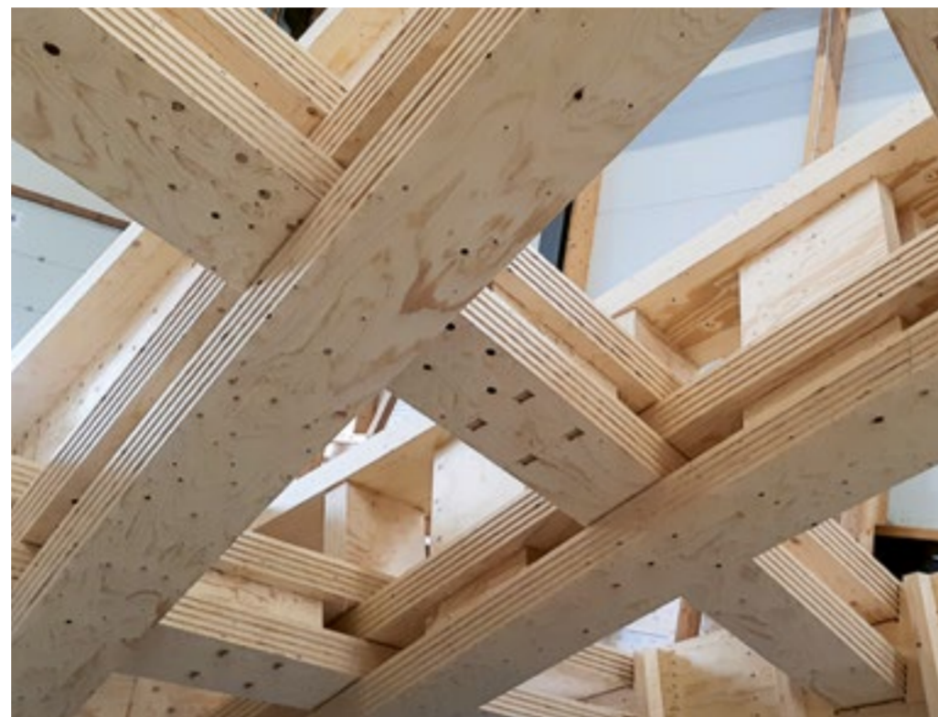
Das Mock-up baute Vertrauen auf. Bei der Bauherrschaft, bei den Lieferanten sowie innerhalb unseres Projekt- und Montageteams. Gut sichtbar: die 5 Lagen der Träger, die aus je 5 LVL-Lamellen bestehen. Ebenso sind die Schubdübel zu sehen, die die Trägerlagen verbinden.
