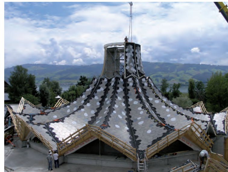
De hoed heeft plooiën, een schacht die ook uit elementen bestaat en op twee ringen steunt én een asymmetrische cilinder als bekroning.
