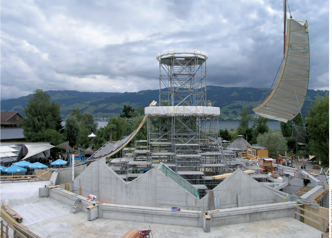
Veel rekenwerk zat in het precies laten aansluiten van de elementen op de betonnen fundering.
