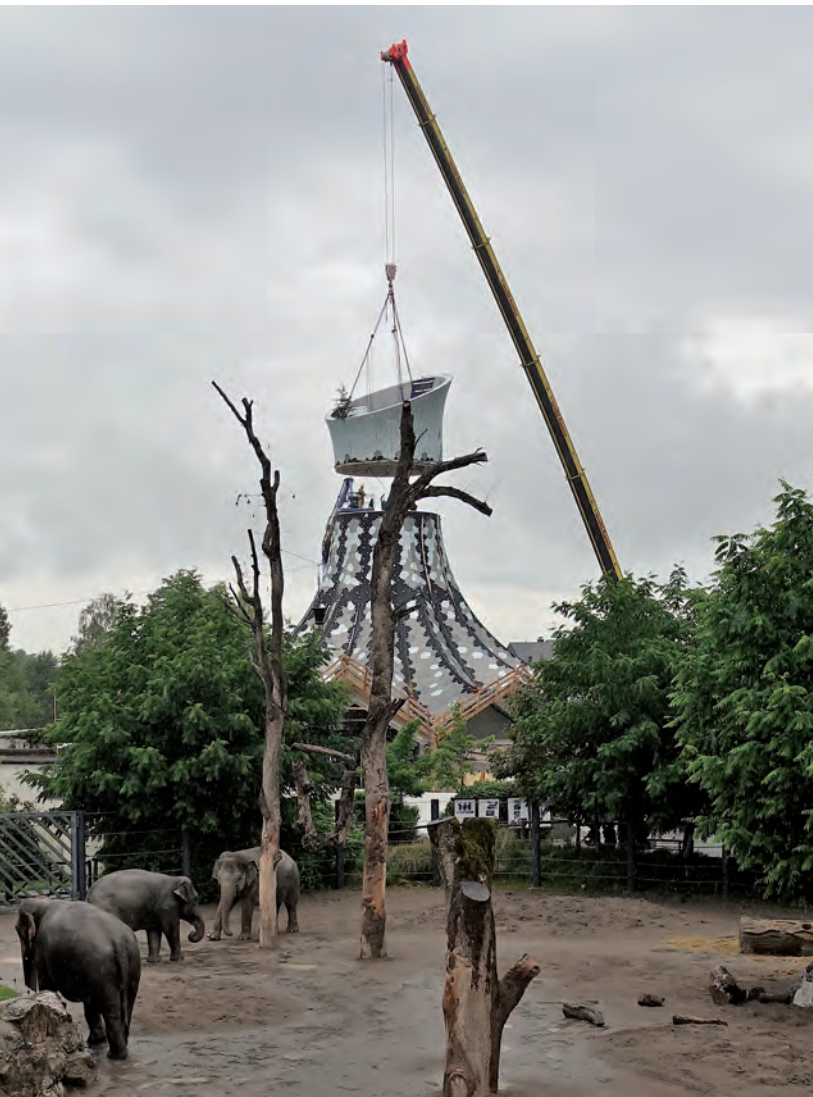
De asymmetrische bekroning is geprefabriceerd, weegt 20 ton en werd in zijn geheel in een keer geplaatst.
